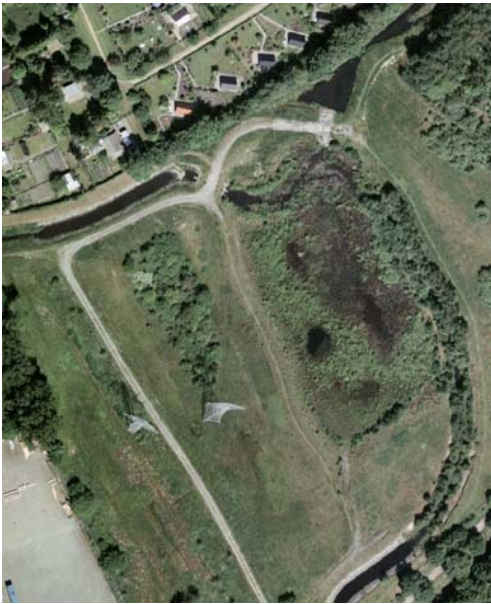
Foto 5: Luftbild des Regenrückhaltebeckens Geestemünder Markfleet
