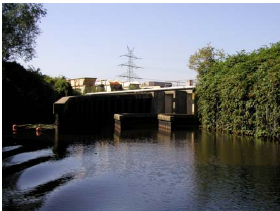
Foto 7: Ablauf des Mischwasserrückhaltebeckens an der Müllverbrennungsanlage
