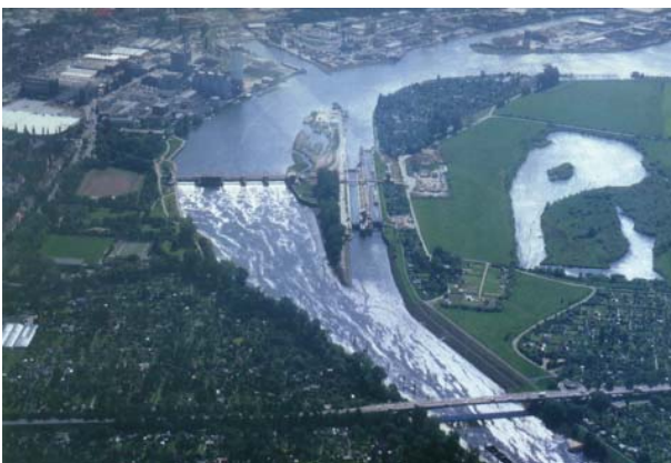
Foto 2: Weserwehr in Hemelingen (Fischtreppe am linken Weserufer vorhanden)
