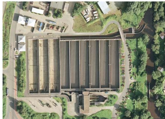
Foto 8: Luftbild des Mischwasserrückhaltebeckens an der Müllverbrennungsanlage
