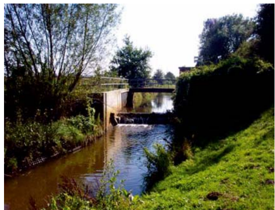
Foto 3: Stauvorrichtung am Deichschlot
