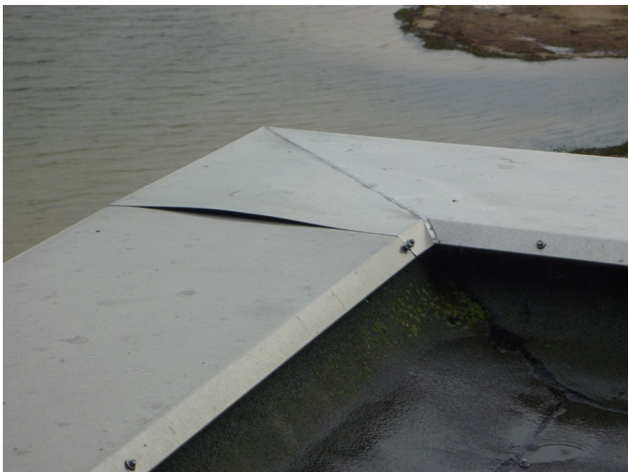
Verschraubte Attikaabdeckung mit aufgebogenem Blech
