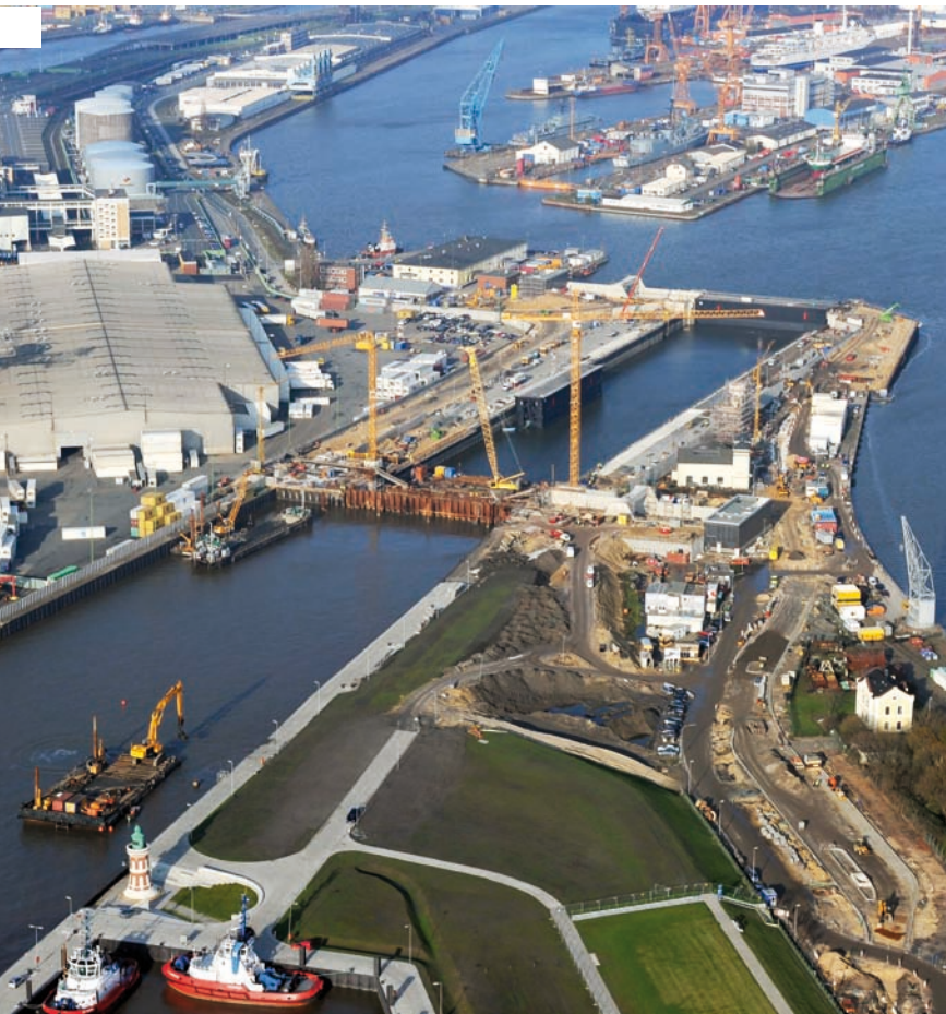
Bau der Kaiserschleuse in Bremerhaven
