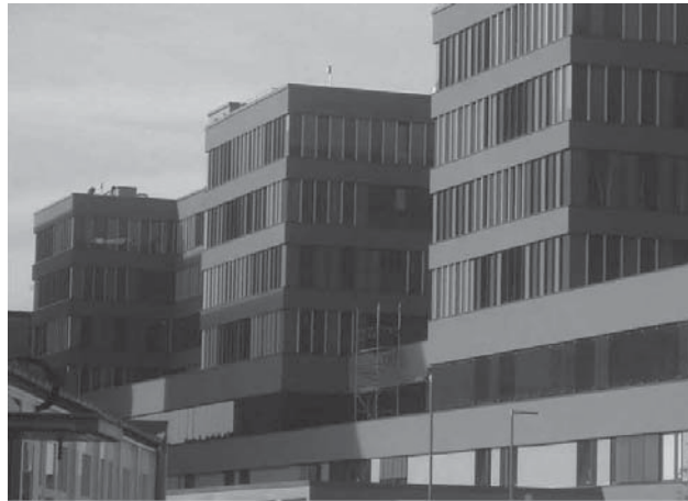
Neubau Klinikum Offenbach am Main 434
