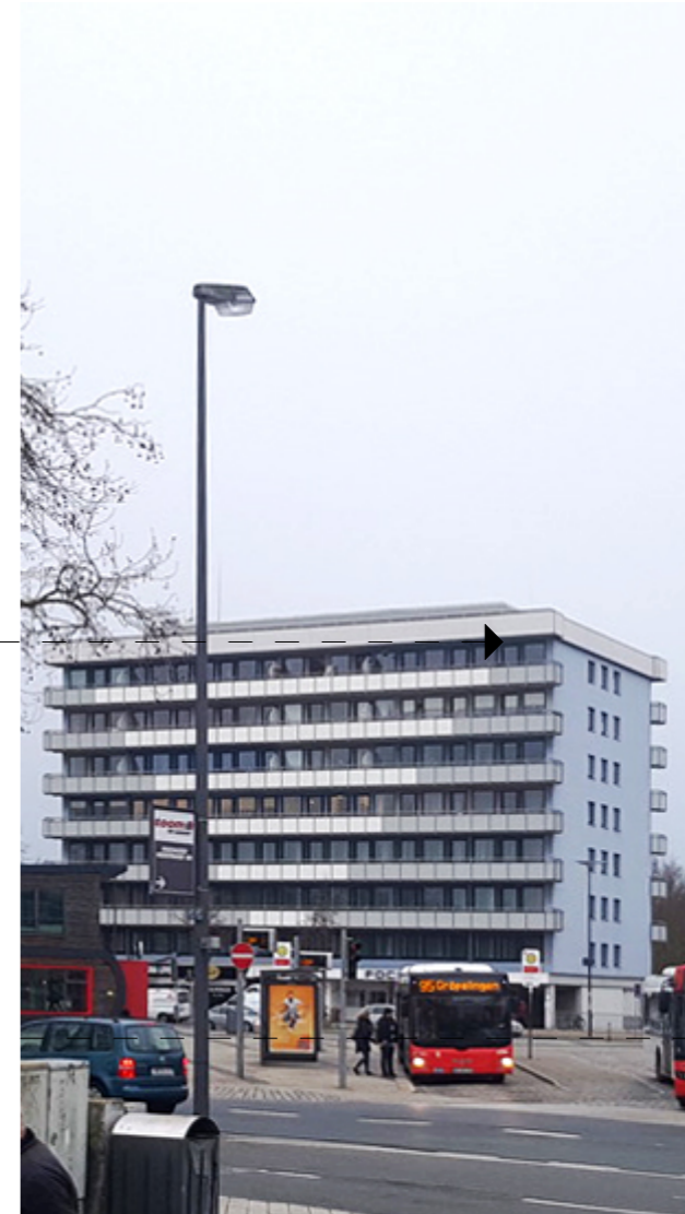
Gebäude am Vegesacker Bahnhofplatz 2 8 Geschosse
