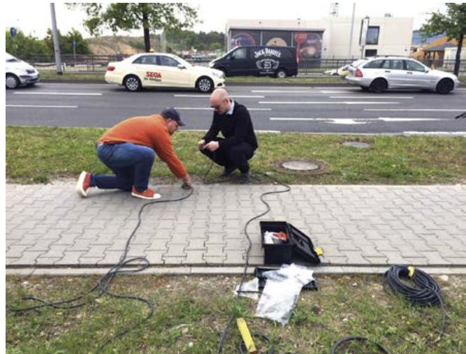
Abbildung 27: Aufbau der Fahrradzählstellen
