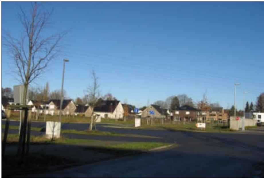
Hamfhofsweg nach Fertigstellung...
