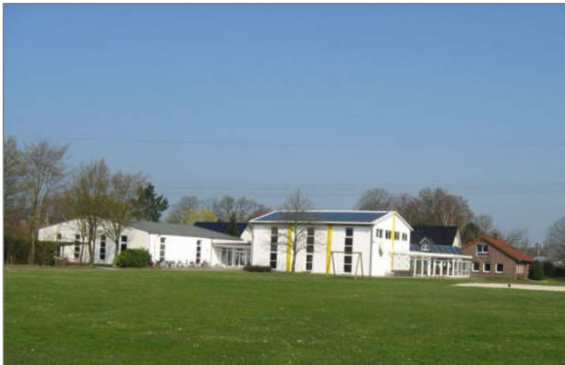
Sportanlage des SC Borgfeld
