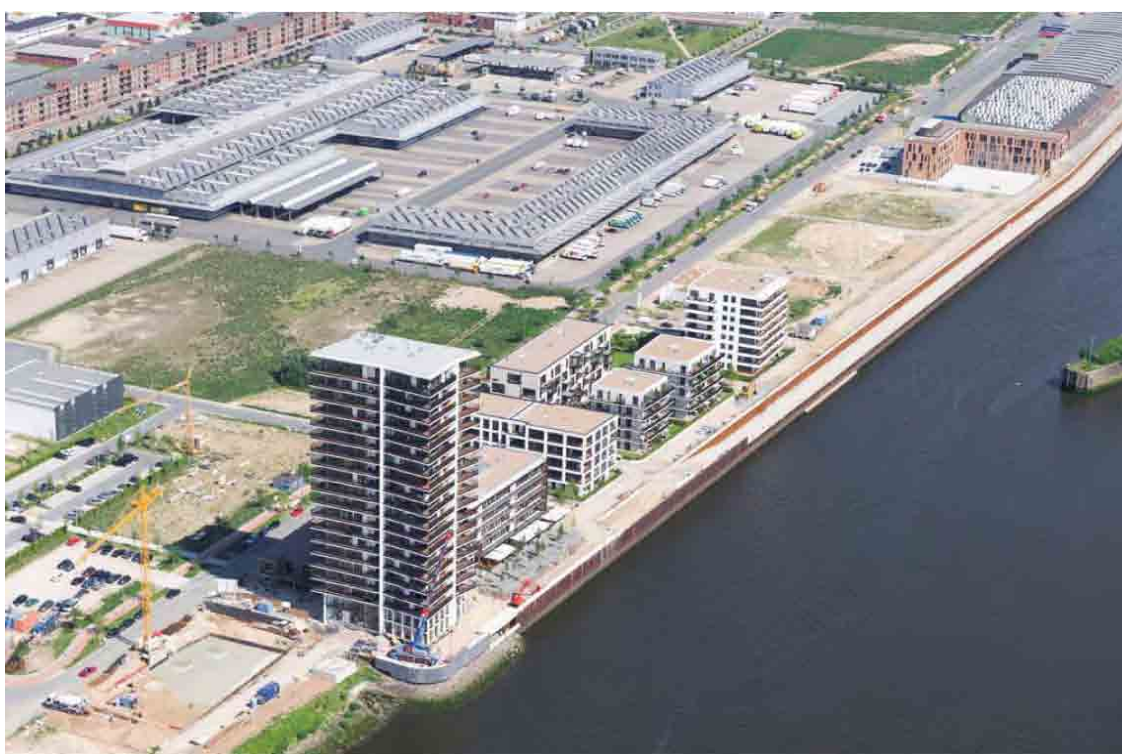
Abb. 25 Luftaufnahme Flächen westlich Schuppen 3 - 2011
