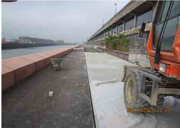
Abb. 20 Oberflächengestaltung obere Promenade vor Schuppen 1
