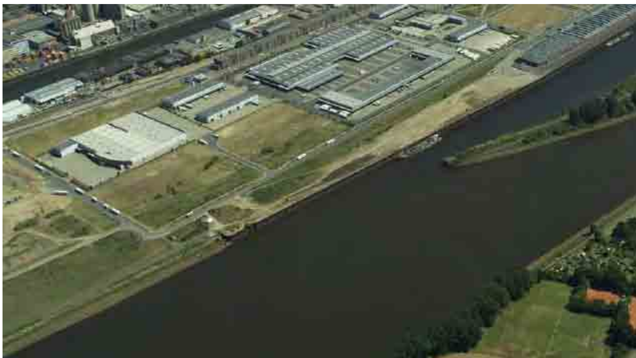
Abb. 24 Luftaufnahme Flächen westlich Schuppen 3 - 2008
