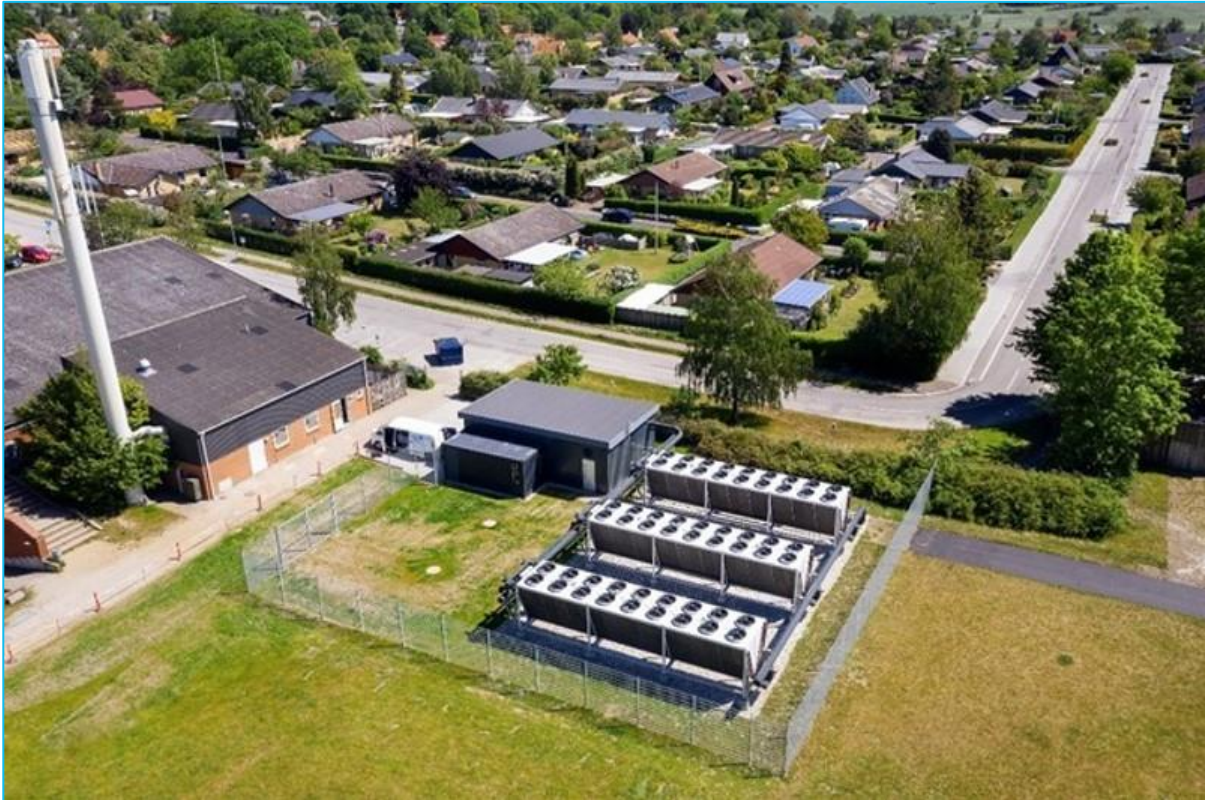
1 MW Luft-Wärmepumpe in Slagslund, Dänemark (Grafik: PlanEnergi)
