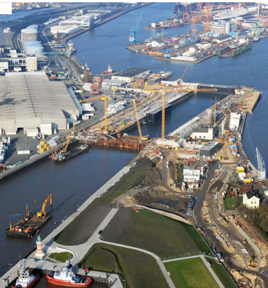
Bau der Kaiserschleuse in Bremerhaven
