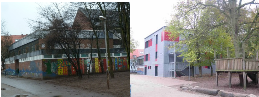
Abbildung 7: Turnhalle Carl-Schurz-Str. vor und nach Sanierung/Umbau
