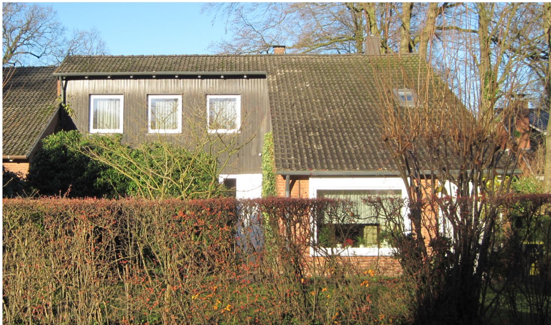
Abbildung 27: Reihenhausesansicht Gartenseite (Quelle: Bauamt Bremen-Nord)
